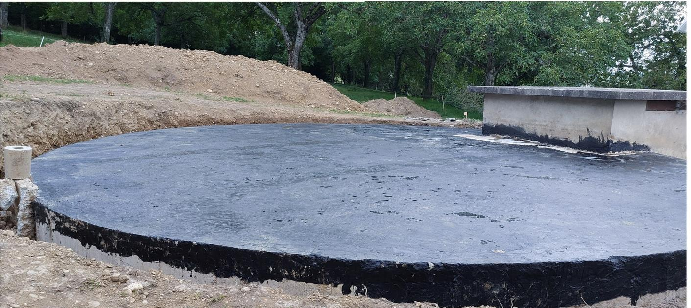
Un bitume spécial a été appliqué sur tout le « couvercle » pour éviter les infiltrations d'eau par les microfissures.
